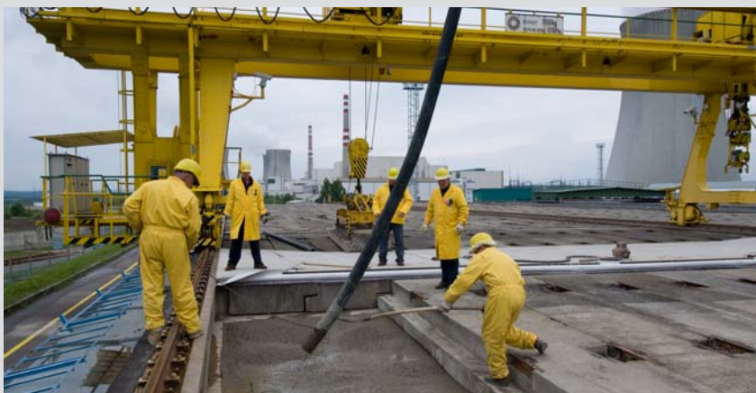
Betonáž ukládací jímky.
