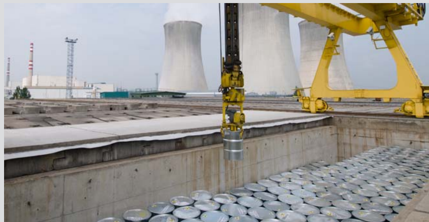
Uložené radioaktivní odpady v ukládací jímce.
