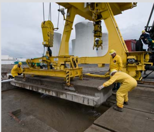
Překrytí zabetonovávané jímky panely.
