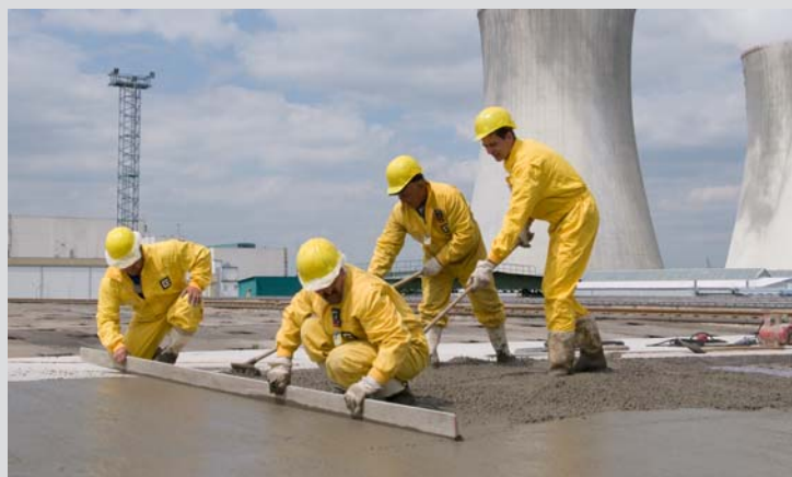
Konečná betonáž na povrchu překryvných panelů.
